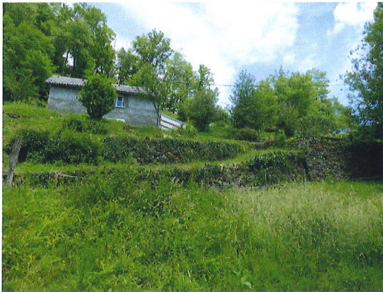
les murets de soutènement devront être conservés
