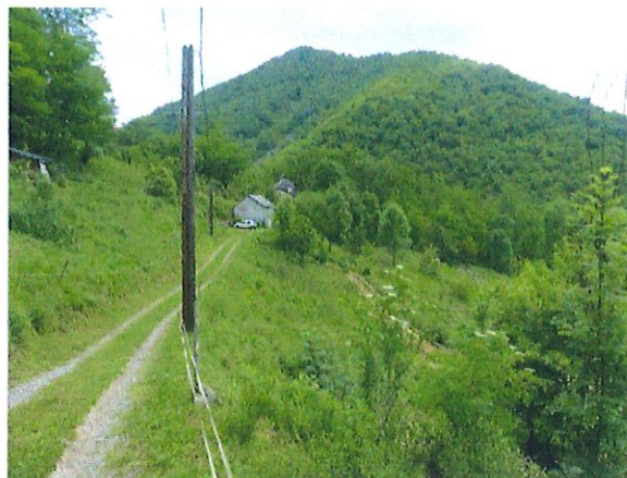
les cables électriques devront si possible être mis en souterrain
